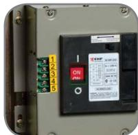
ВА-99М EKF Basic номиналом на 1250 А и 1600 А имеют установленный электропривод
